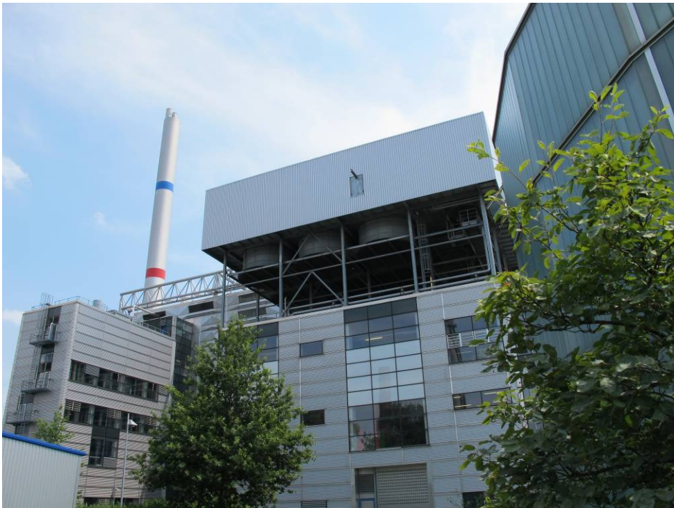
Müllheizkraftwerk des Zweckverbandes TAD Ulm
